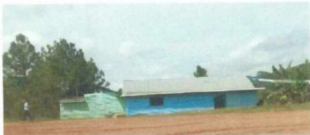
Foto 1: Vista panorámica de la escuela con daño en cocina por lluvia y viento.
