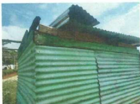
Foto 5: Techo de sanitarios con daño en su estructura por humedad.
