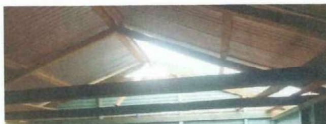
Foto 6: Estructura de madera de aula con daño por viento y lluvia de la temporada.
